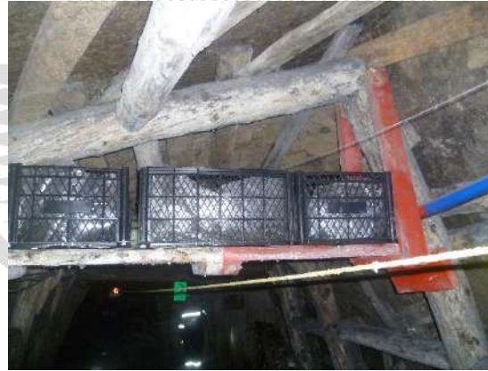
Şekil.4 Su Bekleme barajı
